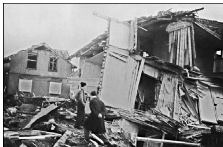
Ødeleggelsene i Lillestrøm var store og hjelpekorpsset gjorde en formidabel innsats. Her fra Bakker-gården (Sørums-gata 28). Foto: T. Larsen
